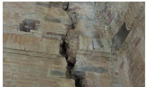
Fig. 10- I presidi in materiale lapideo utilizzati per ammorzare due paramenti interessati da una lesione, successivamente solleccitati e rotti da un nuovo movimento sismico
