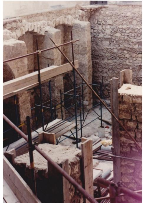
Fig. 7- Strutture presenti all'interno del baluardo Dusay (In AS-BAPSAE CA-OR, Cartella Cagliari, Complesso di San Pancrazio, perizia 33/92, del 10 agosto 1992; immagine pubblicata all'interno della tesi di Laurea di M. Loddo, 2011). Le strutture vengono poste in essere al fine di *terraplenar* il baluardo e consentire l'alloggio di artiglierie pesanti in posizione di “cavalier”
