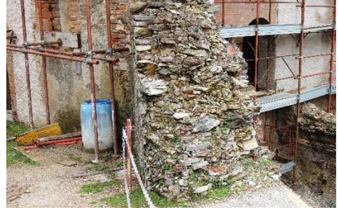
Fig. 9- Sezione a vista di una muratura del XVIII secolo
