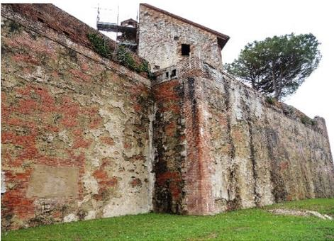
Fig. 5- Il mastio con i resti dell'intonaco originale
