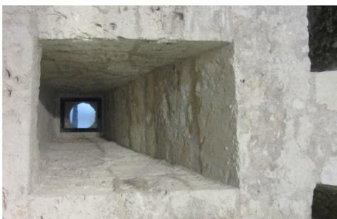
Fig. 15- Dettaglio dell'apertura per artiglieria (settore 2 Fig. 2)
