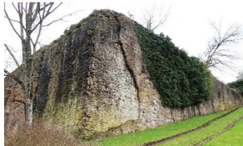
Fig. 7- Un esempio di foderatura esterna in laterizio di un paramento della Fortezza dove risulta ben visibile la scarsa ammorsatura con la muratura interna
