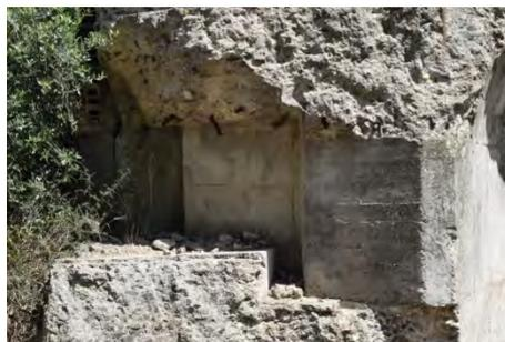
Fig. 3– Fortino parzialmente demolito. Si possono apprezzare le caratteristiche materiche. Strada 25 Ovest. Foto A. Martinez – Medina.
