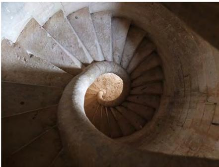
Fig. 2- Escalera de caracol: vista superior con el hueco central helicoidal. (Martínez, 2016).
