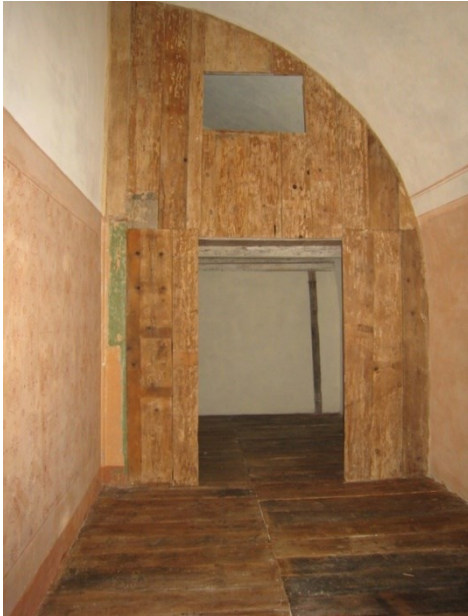
Fig. 7- Forte di Exilles, corpo di fabbrica del “Cavaliere”, una cella dopo il restauro (2008)
