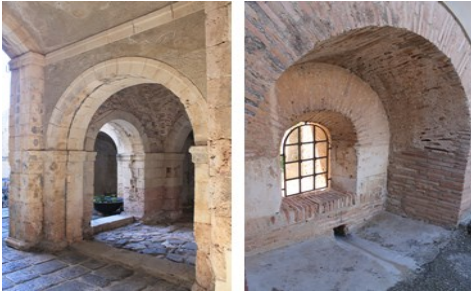
Fig. 11- Il calcare squadrate dei pilastri e i mattoni pieni della e finestra a volta
