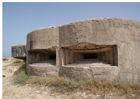
Fig. 6- Vista de uno de los tambores de tiro para ametralladora del IVB13 (Atanasio, 2012)
