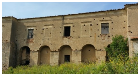
Fig. 13- Interventi con catene e tamponamenti
