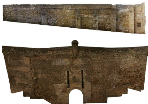
Fig. 10- Proceso de escaneo de la Puerta de la Colada
