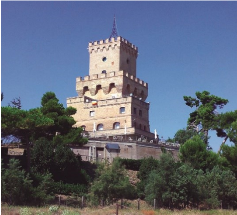
Fig. 4- Torre di Cerrano, lato costa-sud (foto marzo 2018)
