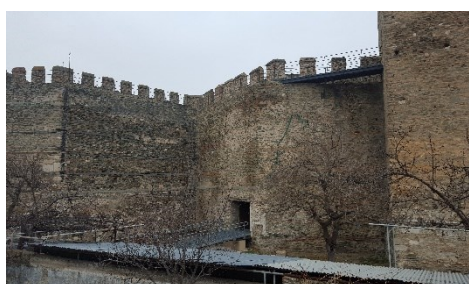
Fig. 9- Eptapyrgio , Salonicco. Il cammino di ronda, planimetria complessiva, vista generale e particolare fronte est
