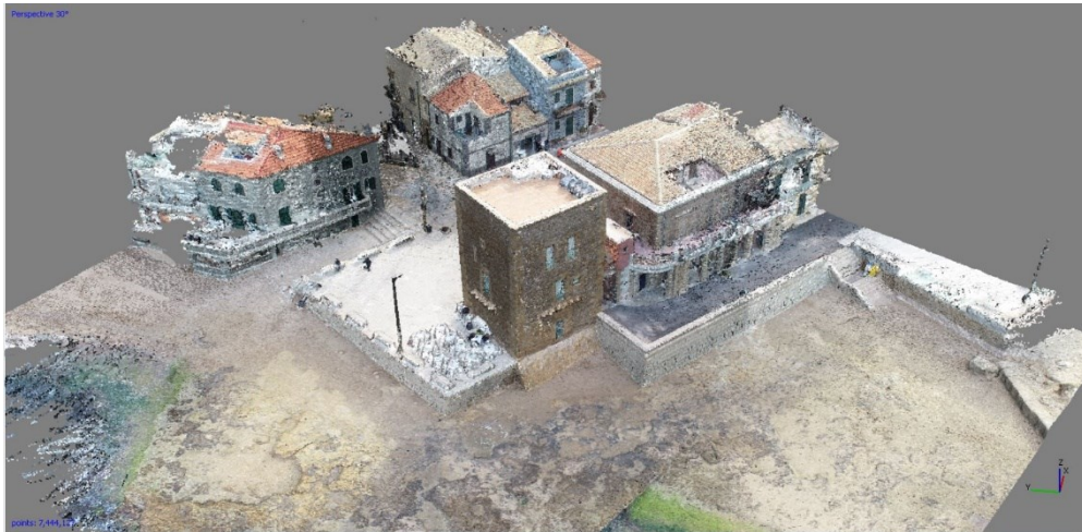
Fig. 8- Torre Scalabri. Point Cloud
