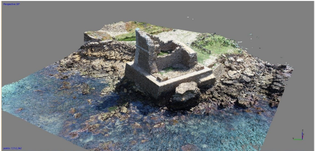
Fig. 6- Torre di Mezzo. Point Cloud
