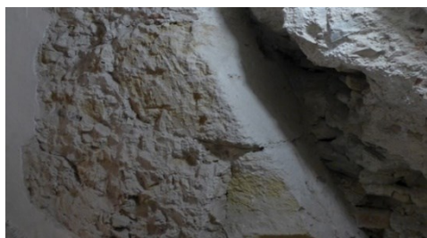
Fig. 6- Cortine laterizie a piombo con beccatelli, ritrovate nel corso dei lavori di restauro della seconda metà del '900.
