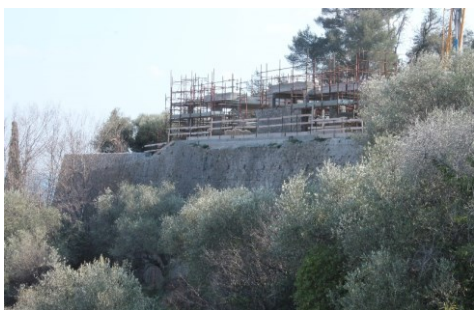
Fig. 13- Vista del fianco del mezzo baluardo San Jago e del cantiere per la costruzione di nuovi corpi di fabbrica
