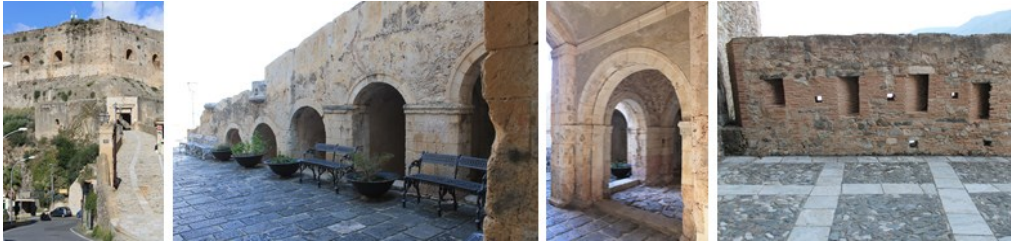
Fig. 8- La rampa di accesso, vista d'insieme e particolari del percorso
