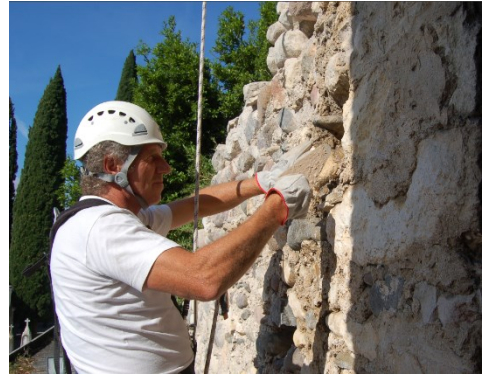
Fig. 6- Castello di San Felice del Benaco, stilatura dei giunti (Scala, 2010)
