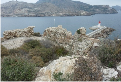
Fig. 4- Visión de la entrada a la bocana del puerto desde la Torre Navidad y estado actual del interior de la edificación. (P.E. Collado)
