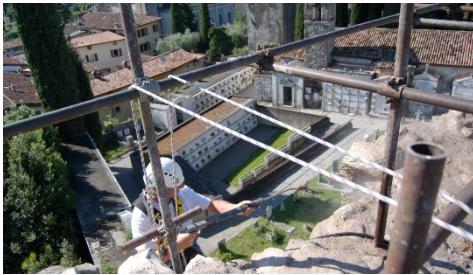
Fig. 5- Castello di San Felice del Benaco, lavaggio delle superfici (Scala, 2010)
