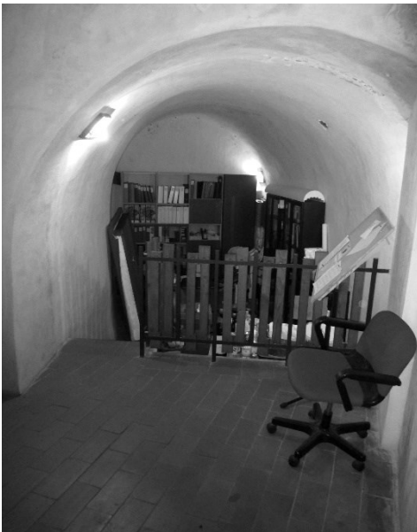
Fig. 8- Tunnel voltato presente all'interno della chiesa di Santa Maria del Monte
