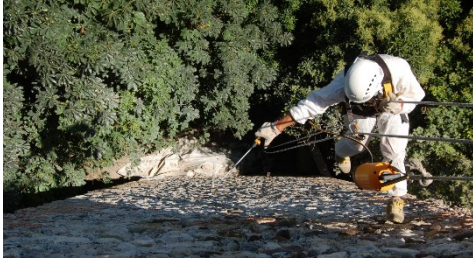
Fig. 4- Castello di San Felice del Benaco, stesura del biocida (Scala, 2010)
