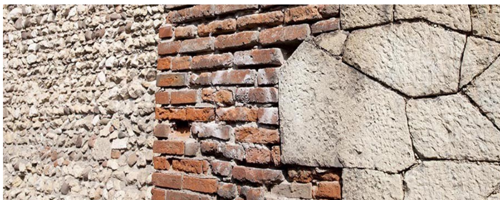
Fig. 2- Dettaglio del paramento murario nel quale si evidenziano diverse soluzioni costruttive: partendo da sinistra tratto di mura scaligere, veneziane e quindi le poligonali austriache
