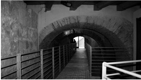
Fig. 11- Ammorsamento delle strutture settecentesche ad elementi appartenenti alla linea di difesa tre-quattrocentesca (Mattana, Schirru 2003)
