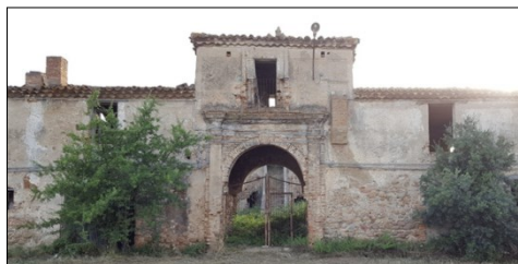
Fig. 8- Porta arcata con la vista dello scalone
