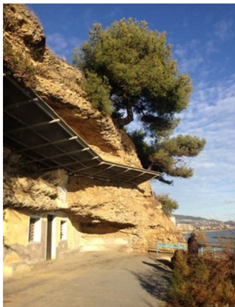
Fig. 5- Il lato del complesso verso il mare; per un confronto storico vedi fig. 2
