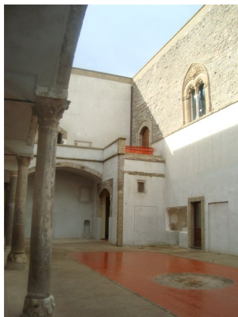
Fig. 2- Il cortile interno durante i lavori
