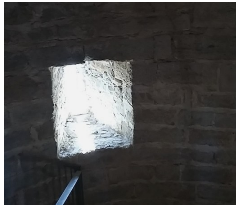
Fig. 8- Feritoia vista dall'interno, torre di Castellino Tanaro, immagine dell'autore 2017
