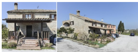
Fig. 11- Casa Porte di Ferro. Prospetto Sud (a sinistra) e vista di scorcio dei prospetti Ovest e Sud dell'edificio (a destra), (F. Giansanti, P. Formaglini, S. Giraudeau, A. Giacomelli, 2018)
