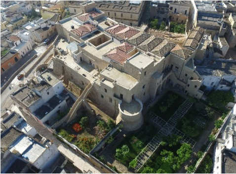
Fig. 4- Vista aerea dell'area del castello da nord-ovest (2016)
