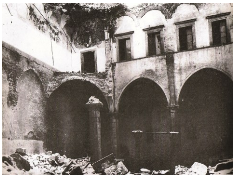
Fig. 3- Interno del castello di Celano dopo il sisma del 1915 (Soprintendenza, 1989)
