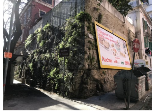
Fig.11- Il bastione San Vincenzo, foto dell'autore. Anche questo bastione, posto stavolta nella cortina nord della cinta muraria, prendeva il nome da una chiesa non pervenutaci. Sul fianco vi è l'innesto della parete che scendeva verso il mare, correndo sulla attuale Via Fossata, toponimo che richiama la presenza di un torrente che veniva sfruttato quale fossato per le mura. Mentre verso ovest le mura proseguivano verso il bastione Andria
