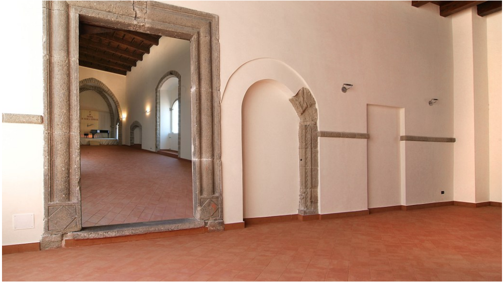
Fig. 3- Passetto e grande salone al primo piano a lavori completati
