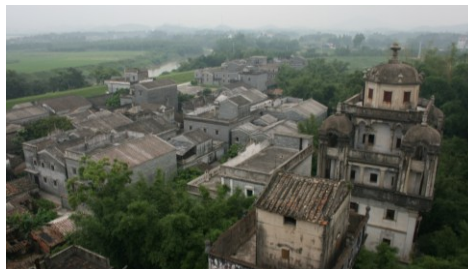
Fig. 9- Vista dall'alto di un insediamento residenziale composta da case a corte e dialou (immagine Calia, 2010)
