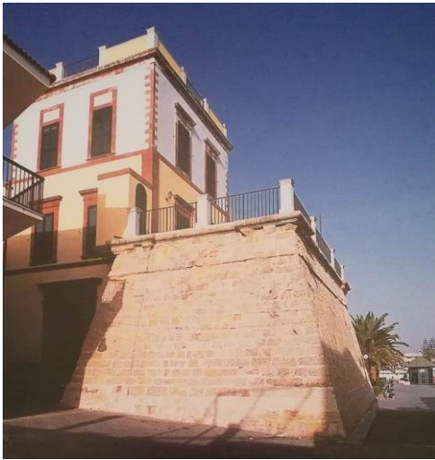
Fig. 7- Marina di Ragusa, torre Mazzarelli
