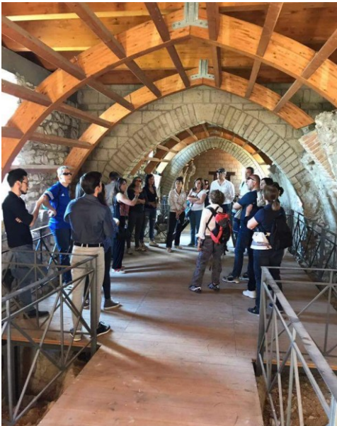
Fig. 7- La fruizione dopo il restauro
