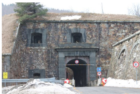
Fig. 12- Il Forte Centrale sul valico del colle del Melogno, provenendo da Finale.
