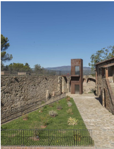
Fig. 3- Vista del nuovo sistema di risalita (Ciampi, 2017)
