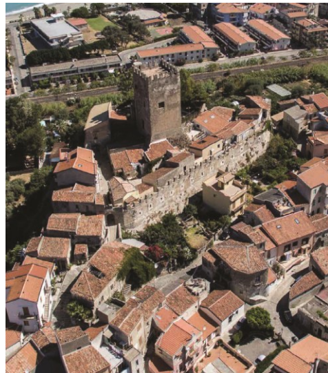
Fig. 1- Veduta aerea del castello di Brolo
