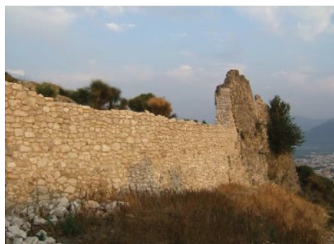
Fig. 4-5- La cinta muraria intermedia (prima e dopo l'intervento di consolidamento)
