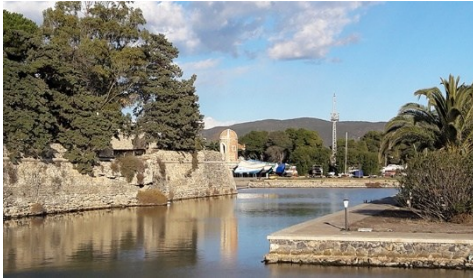
Fig. 12- Vista di un tratto delle mura sulla laguna (foto Chiavoni, 2018)
