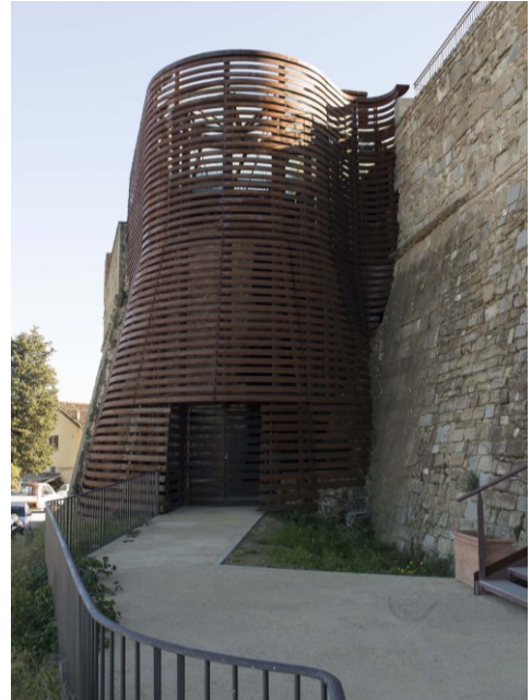
Fig. 4- Il bastione di Soccorso in acciaio e vetro (Ciampi, 2017)
