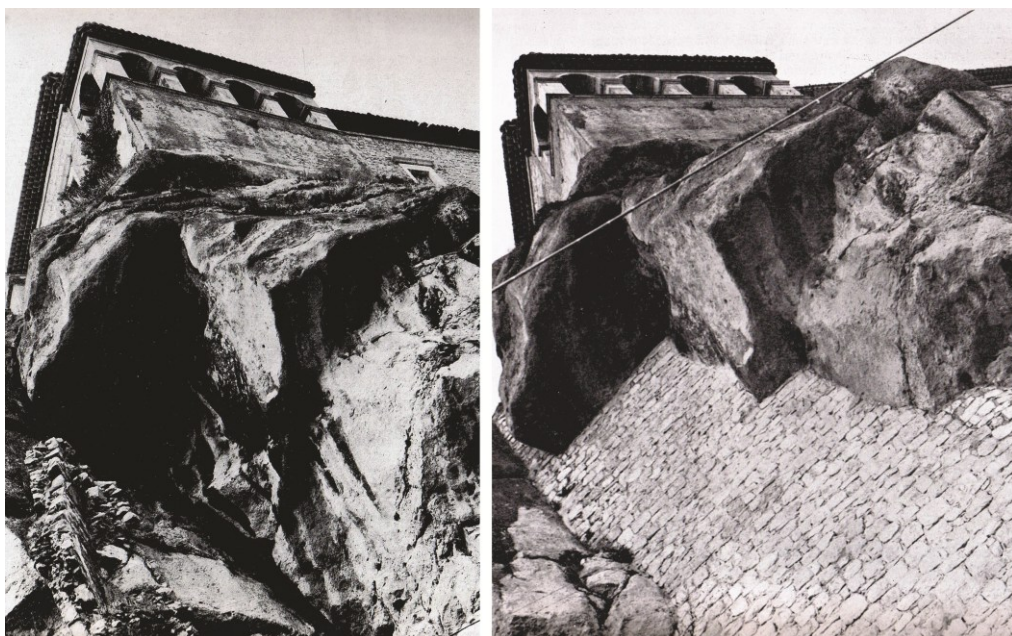
Fig. 2- Il castello ducale di Palena prima e dopo l'intervento di restauro (Moretti, 1972)
