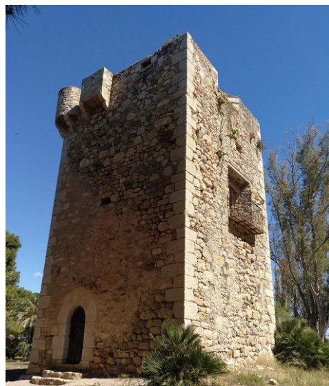
Fig. 7- Estado actual. Vista desde el Este (Foto: J. Prior, 2018)
