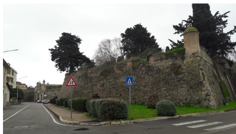
Fig. 10- Veduta delle mura sul lato destro della porta di Medina Coeli (foto Chiavoni, 2018)
