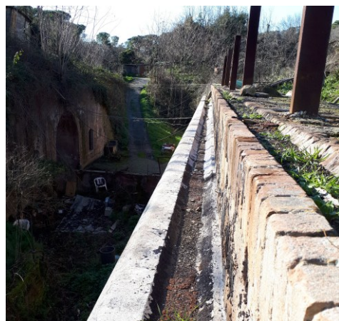
Fig. 3- Il canale di raccolta, delle acque, sul muretto del traversone e l'incavo nella cornice in travertino
