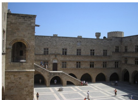
Fig. 6- Palazzo del Gran Maestro, cortile, vista sul prospetto est. (Onofrio Schillaci, 2010)
