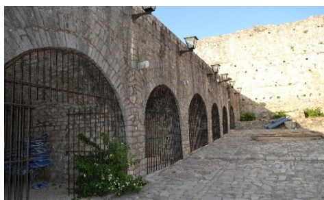
Fig. 9- Dulcigno, Montenegro, vista degli arsenali (particolare)
