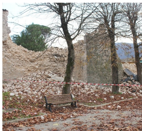
Fig. 3- Tratto nord-ovest delle mura (2017)
