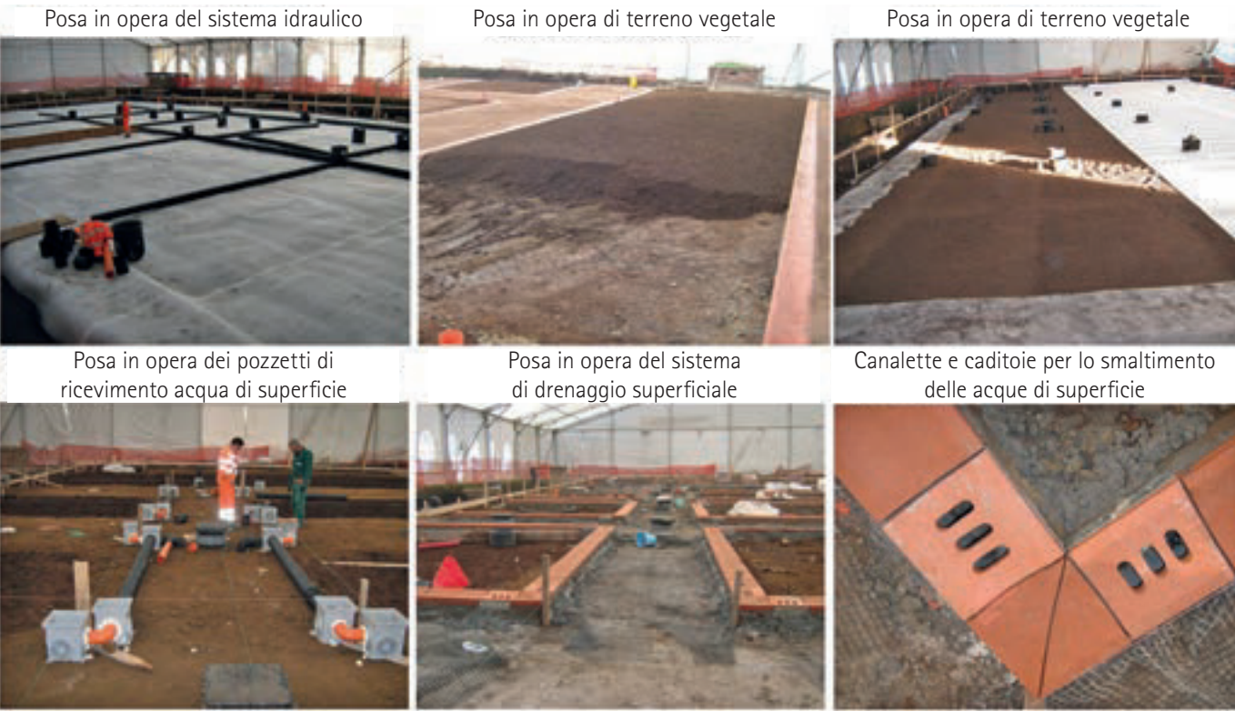
Fig. 4 Il giardino sostenibile, posa in opera del sistema di smaltimento delle acque di superficie e dei cavidotti per il monitoraggio (Parco archeologico del Colosseo, Archivio)
