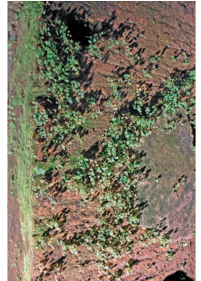
Fig. 8 Domus Aurea, Ambiente 38: fenomeni di biodeterioramento (Parco archeologico del Colosseo, Archivio)
