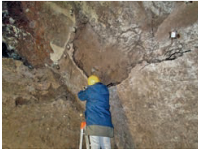
Fig. 2 Domus Aurea, Ambiente 42: fuoriuscita delle radici nell'intradosso della volta (Parco archeologico del Colosseo, Archivio)
