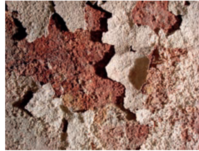
Fig. 7 Domus Aurea, Ambiente 63: spessi strati di carbonatazione in fase di esfoliazione (Parco archeologico del Colosseo, Archivio)
