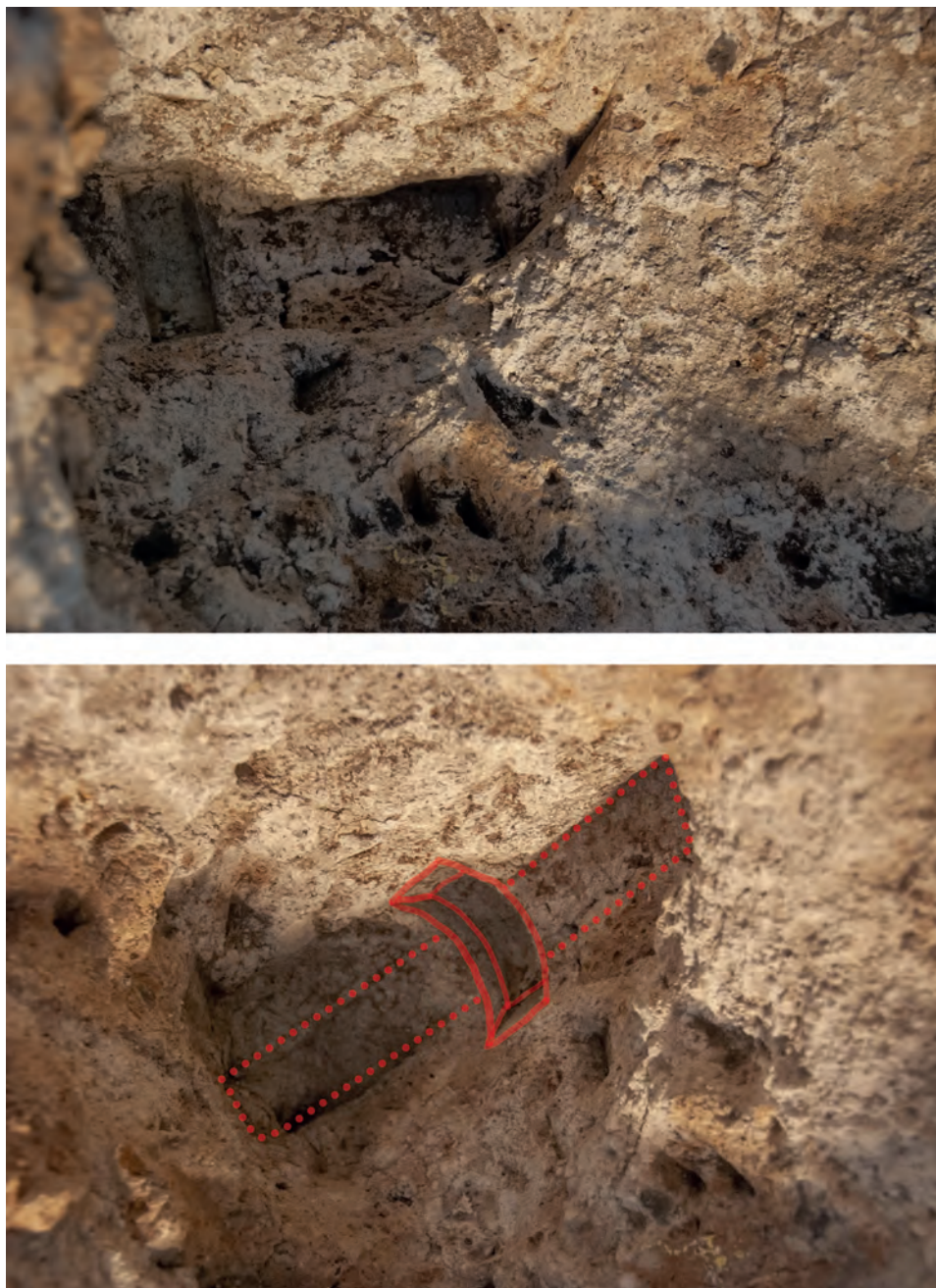
Fig. 8. ROMA. Domus Aurea. Complesso della sala ottagonale: a. impronta relativa all'asportazione n. 2; b. la stessa impronta vista da altra angolazione e con evidenziate le tracce e le forme degli elementi metallici costitutivi (foto ed elaborazione degli Autori).
