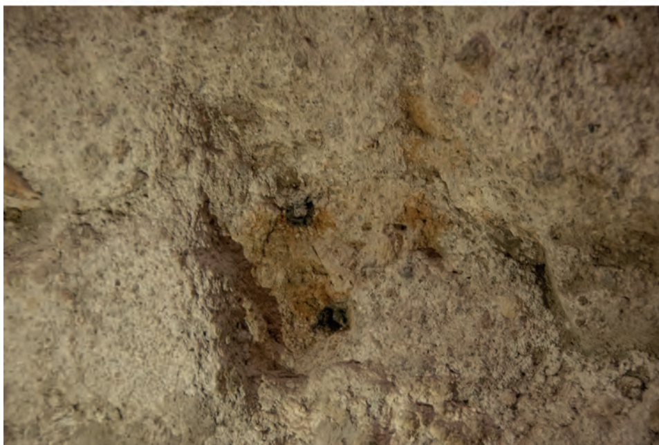
Fig. 12. ROMA. Domus Aurea. Complesso della sala ottagonale, una delle file di coppie di chiodi, collocate lungo i cinque meridiani della cupola (in alto) e dettaglio di una coppia (in basso, foto Autori).
