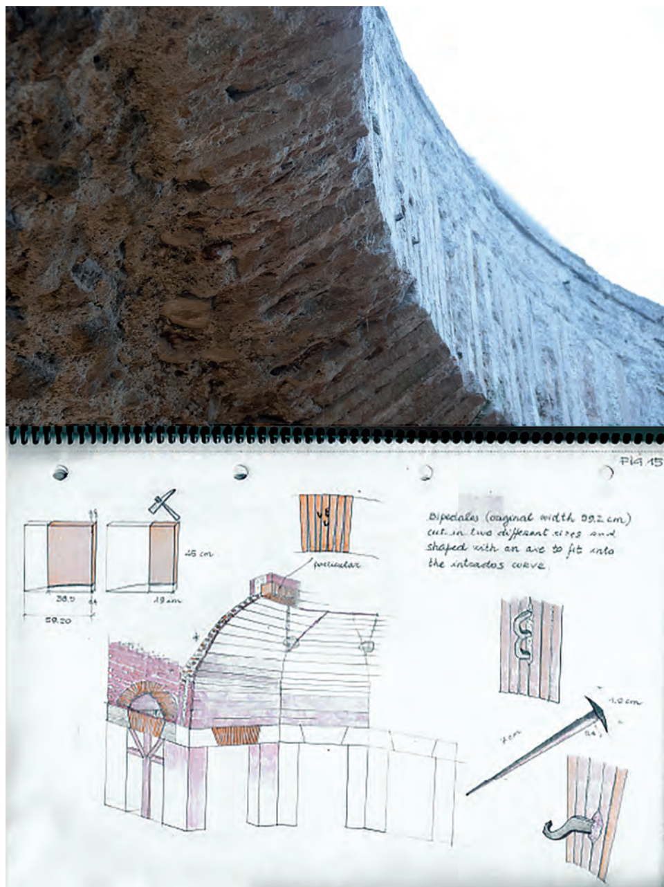
Fig. 6. ROMA. Domus Aurea. Complesso della sala ottagonata, ghiera di bipedali dell'oculo della cupola, con evidenti segni di scalpellamento (in alto, foto autori) e appunto di C. Conti e G. Martines, da cui si evince il dettaglio tecnico del trattamento dei singoli laterizi della ghiera (in basso, poi confluito in CONTI, MARTINES 2010).
