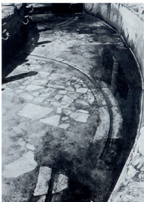
Fig. 13. Esempi dell'uso di rotaie ricavate in negativo su superfici piane: a. PRIENE. Tempio di Atena Polias. Guida per la movimentazione della porta del tempio (foto S. Borghini); b. TIVOLI. Villa Adriana. Cd. Teatro marittimo, binari di scorrimento dei ponti levatoi (da UEBLACKER 1985, tav. 28 figg. 1-2).
