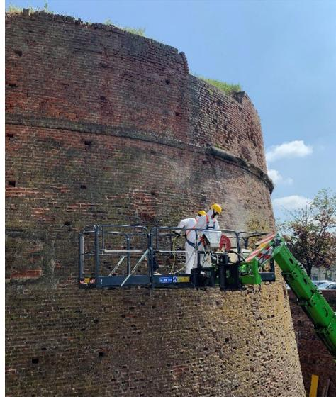
Fig. 1– Trattamento biocida (Gentilini, 2022)
