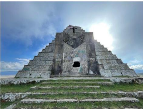
Fig. 13- Estado actual de la fachada sudeste con los peldaños de acceso y la entrada parcialmente tapiada.
