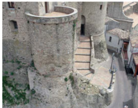
Fig. 3- Castello di Oriolo, accesso principale
