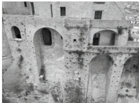
Fig. 6- Castello di Oriolo, fronte con arcate
