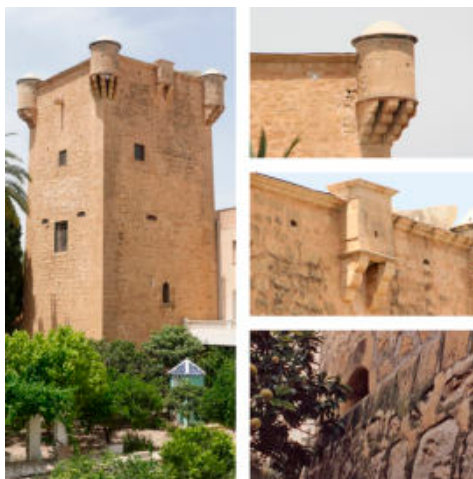
Fig. 5- Torre del Convento de la Verónica-Santa Faz. Vista general de la torre, de una garita, de la ladronera y de una cañonera de la planta baja sobre alambor (Màrius Bevià i Garcia & Jaime Manuel Giner Martínez)
