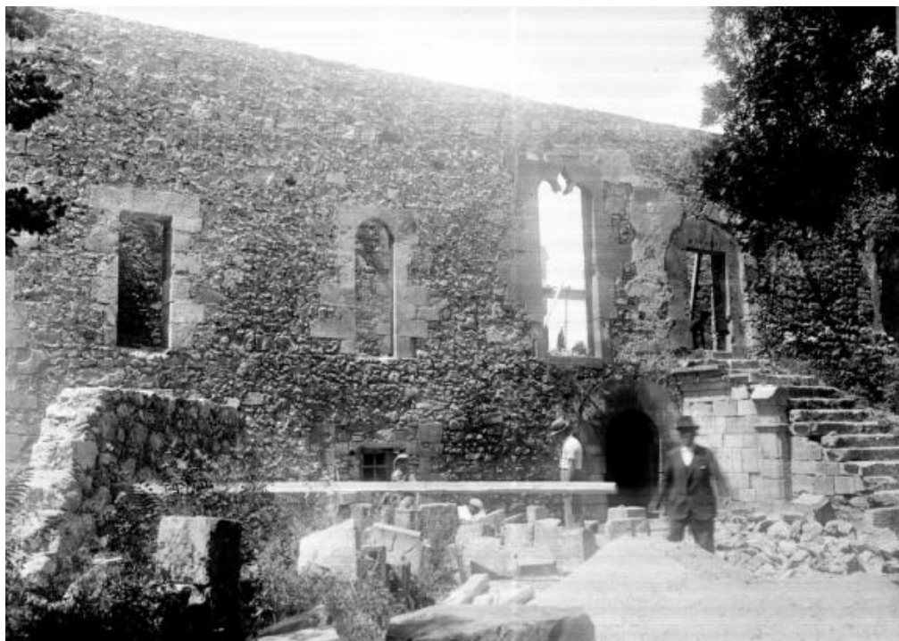
Fig. 6- Laconi (OR), Castello, corte interna, prime opere di ricomposizione degli elementi decorativi [ante 1930] (Archivio SABAP SS, lastra fotografica 14088)
