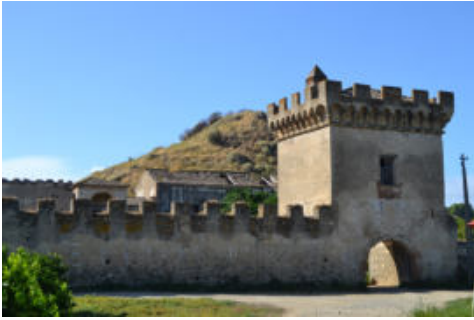
Fig. 6- Corigliano Calabro: castello-masseria San Mauro (foto di B. Canonaco)
