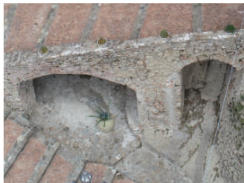
Fig. 8- Castello di Oriolo, volta a sesto ribassato ed arco a sostegno della scala d'ingresso
