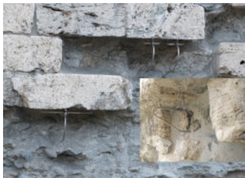
Fig. 10- Serie di sostegni in acciaio messi in opera a sostegno del rivestimento in travertino (progetto e foto di C. Pedeli, realizzazione Carpenterie Acerbi)
