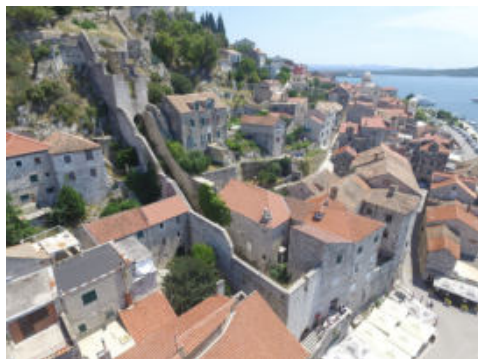
Fig. 2- Veduta aerea della strada di soccorso (Bilić et al. 2019).
