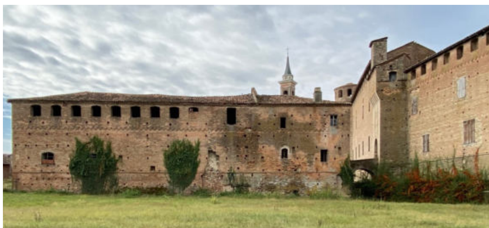
Fig. 2- La cosiddetta 'scuderia' del castello di Calendasco, Piacenza (foto di Michela Marisa Grisoni, 2022). Al disotto della gronda corre la sequenza di "finestrelle" sotto le quali si legge il motivo a dente di sega realizzato disponendo i laterizi in lieve aggetto
