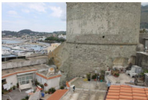
Fig. 4- Il Torrione: volumi edilizi addossati al versante occidentale (Annamaria Ragosta, 2017)
