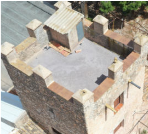
Fig. 6- Imagen tomada por el dron de la cubierta (imagen de los autores)
