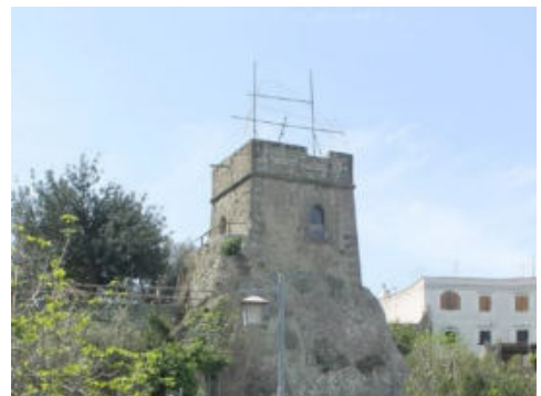
Fig. 7- Torre Nacera (Annamaria Ragosta, 2016)
