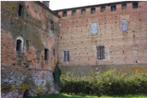
Fig. 11- Sopraelevazione del fronte del castello rivolto verso il 'rustico' (Badan, 2021)
