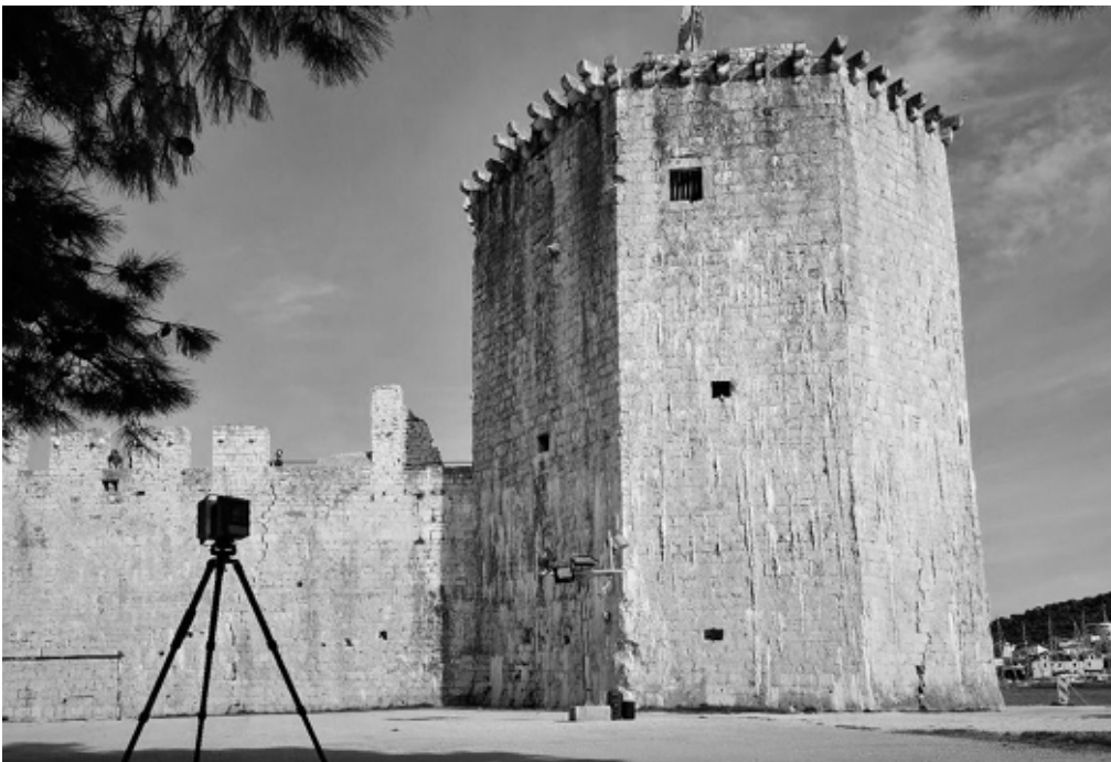
Fig. 1 - Veduta della torre del castello del Kamerlengo (Marco Ricciarini, 2019)
