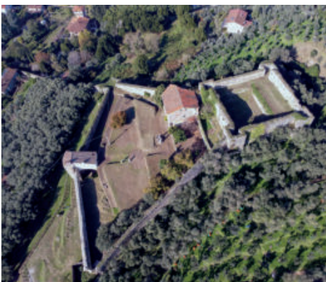
Fig. 2- Fotografia aerea della Rocca di Sala scattata con drone (G. Frosini, 2020)
