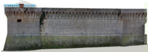
Fig. 2 - Rilievo foto-raddrizzamento della cortina nord della cittadella nuova, 4° stralcio (Archivio Taddei, 2021)
