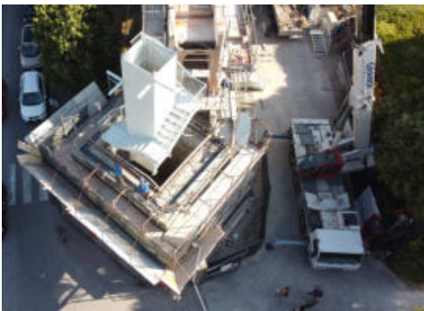
Fig. 11- Varo del primo concio del castelletto all'interno della torre a mezzo di autogrù (foto di Matteo Pierotti, 2022)
