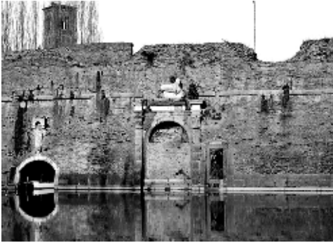
Fig. 1- Accessi a Castelnuovo dal fiume Piovego consentito alle imbarcazioni di entrare in città (Fig. 1). Numerosi elementi lapidei in pietra d'Istria e trachite testimoniano l'importanza che in passato era attribuita a Castelnuovo, il quale sulla sommità presenta 12 troniere per il controllo del territorio circostante.
