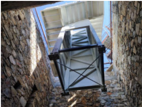
Fig. 10- Fase di calo in basso del castelletto scale-ascensore visto dall'interno della torre (foto di Matteo Pierotti, 2022)
