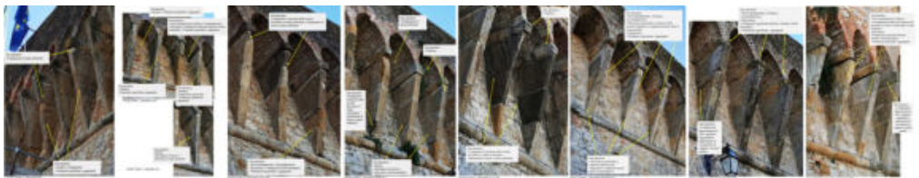
Fig. 12 - Progetto Esecutivo: mensole/beccatelli con indicazione delle tipologie di intervento (Archivio Taddei, 2021)
