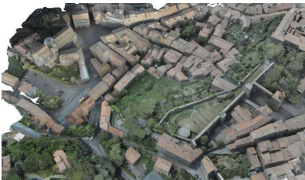
Fig. 6- Vista aerea della mesh ricostruita tramite il drone (elaborazione grafica di S. Giraudeau, 2021)
