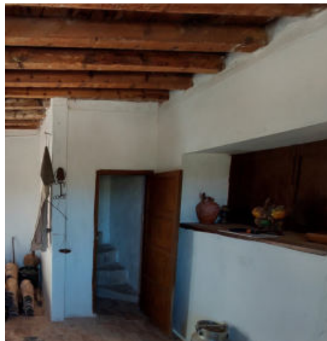
Fig. 4- Interior de la Torre, donde se aprecia el forjado tradicional de vigas y entablado de madera (imagen de los autores)
