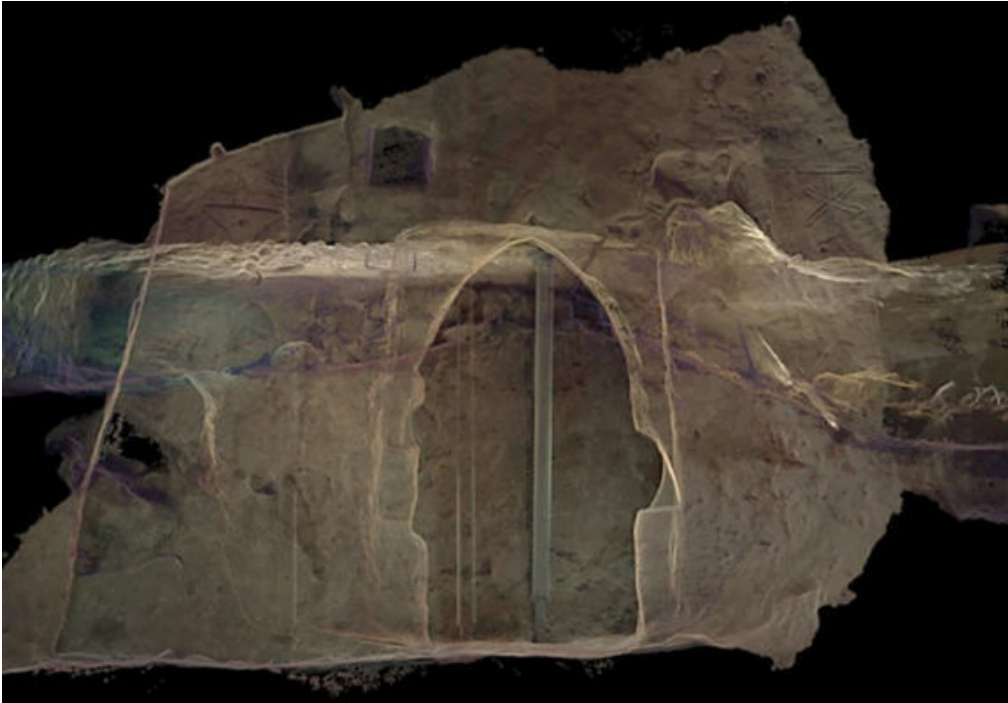
Fig. 8- Elaborazione da rilievo laser scanner 3D. Vista laterale di una porzione della cripta. In evidenza gli aspetti morfologici dell'ipogeo con i graffiti, l'apertura con arco a sesto acuto e l'incasso per l'alloggio della porta lignea (Muscatello & Mitello, 2020)
