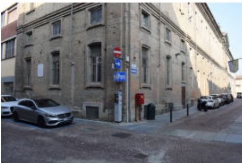
Fig. 6- In primo piano, il corpo monumentale settecentesco; sulla sinistra, l'innesto della manica realizzata a partire dal 1963 (foto dell'autore)
