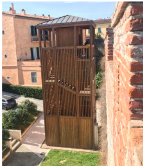
Fig. 7- Torre in legno progettata dagli autori per l'accesso alla parte settentrionale delle mura urbane di Pisa e realizzata nel 2016; l'oggetto del presente intervento ne riprende l'idea (Matteo Pierotti, 2019)
